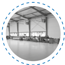
Воздушное отопление и вентиляция
